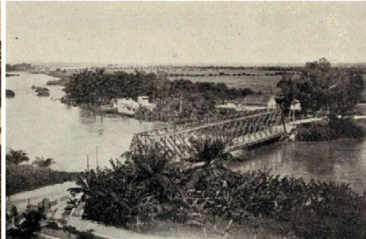
Figura 11. Angola. Ponte de Catumbela.
